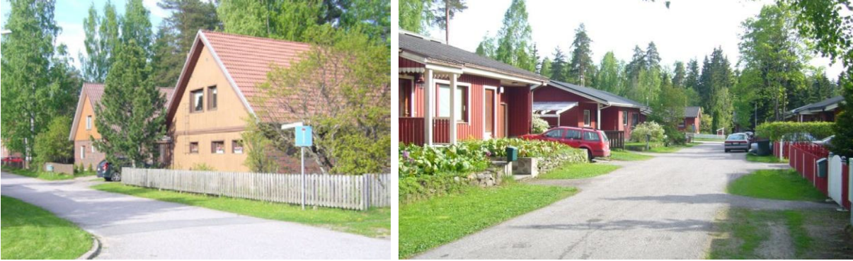
Kuvat 20 ja 21. Sammonlahden itäosan pientaloasutusta ja 70-80-luvun rakennuskantaa Kotisuonkadulla.
