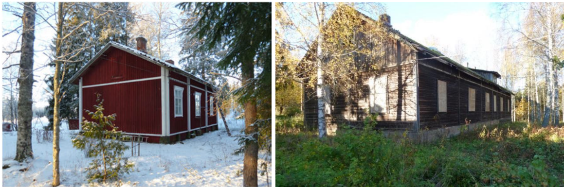
Kuvat 27 ja 28. Entinen Rutolan sahan asuinrakennus ja työläiskasarmi.
