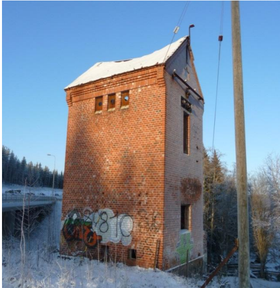
Kuva 26. Muuntamo Myllylammen rannalla.
